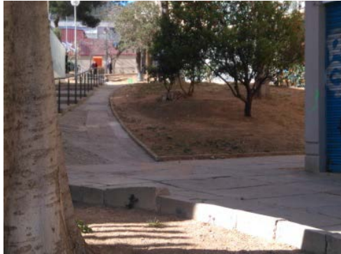
Rampes al C. Harmonia 1
