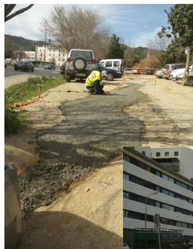
Estat durant l'actuació
