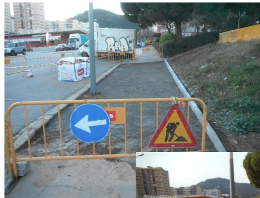
Estat durant l'actuació
