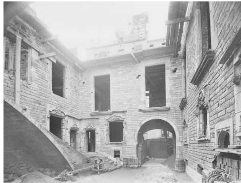
DESMONTATGE DE LA CASA PADELLAS PEDRA PER PEDRA
