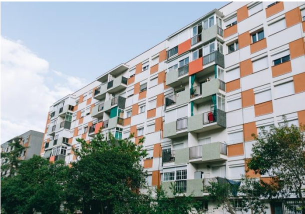
Edifici rehabilitat a c/Vallcivera, Ciutat Meridiana
