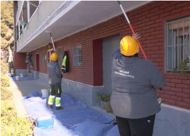
Projecte formació en rehabilitació (Trinitat Vella)
