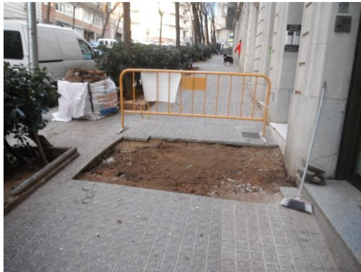
Estat durant l'actuació
