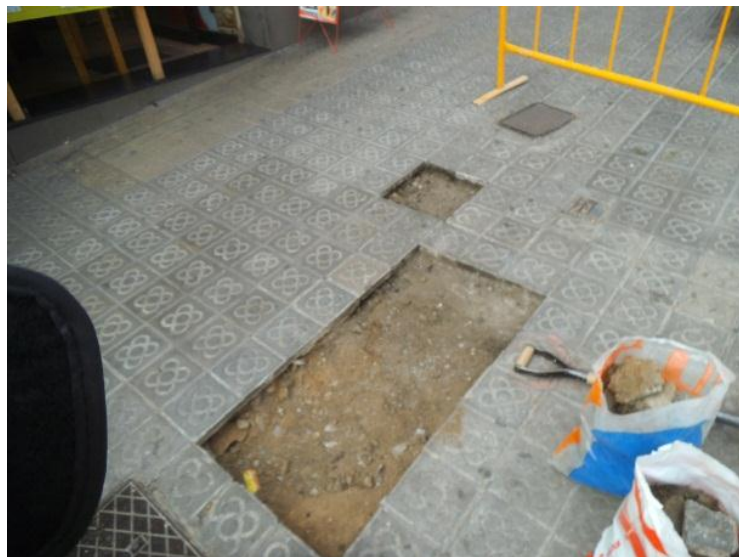
Estat durant l'actuació
