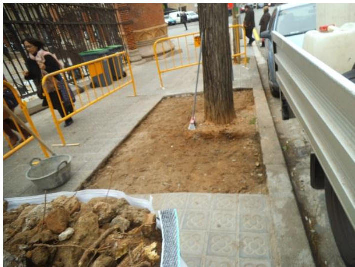
Estat durant l'actuació
