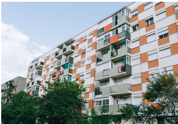
Edifici rehabilitat a c/Vallcivera, Ciutat Meridiana
