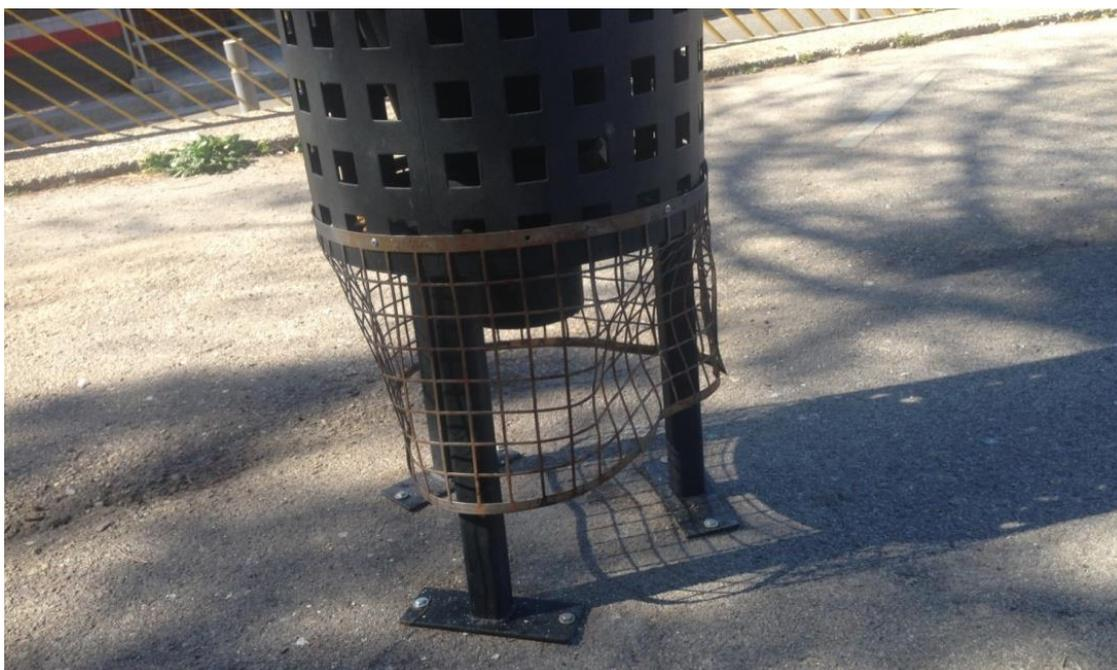
Figura 8. Vandalismo sobre la reja protectora del motor del dispensador.
