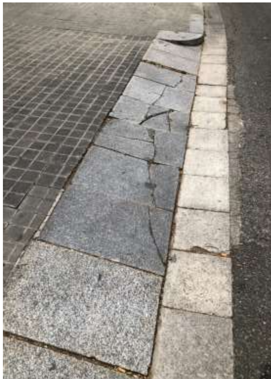
Carrer Tajo, accés gasolinera GALP (Fotos 34 i 35)
