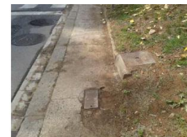
Actual camí formigonat entre les torres Harmonia 35 i 33 col·locat directament sobre el terreny
