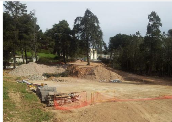
Imatges de l'actuació
