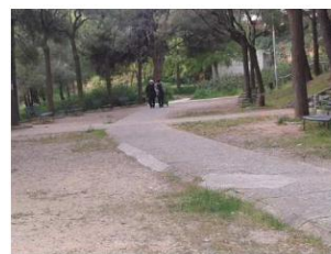
Actual camí formigonat entre les torres Harmonia 35 i 33 col·locat directament sobre el terreny
