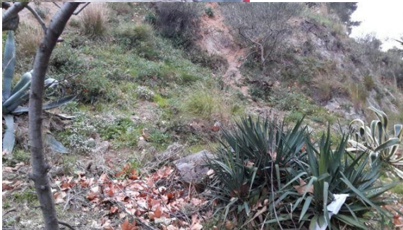
Estat abans de l'actuació
