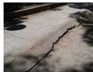
Actual camí formigonat entre les torres Harmonia 35 i 33 col·locat directament sobre el terreny
