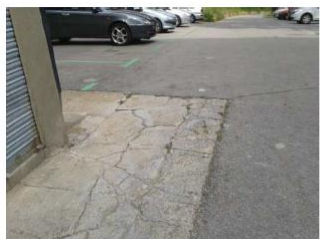
Vorera al voltant de la torre nº 35
