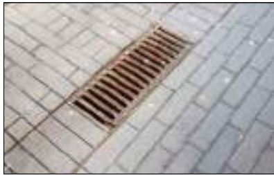
BANDA DE LLOSA SOBRE FORMIGÓ EN LÍNIES DE RECOLLIDA D'AIGUA
