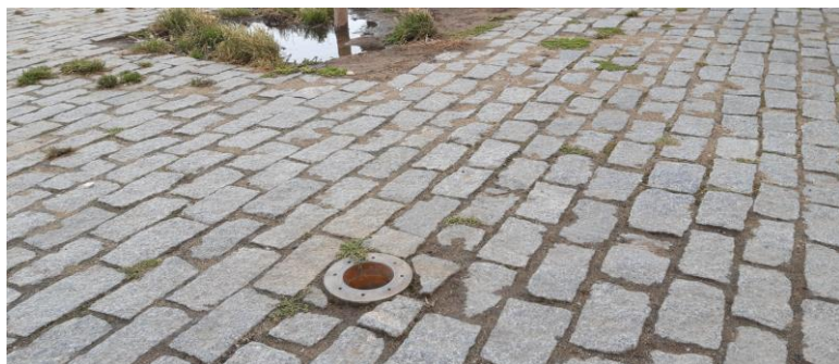
Carrer de Baluard 124
