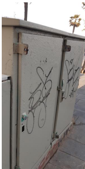
Carrer Drassanes cantonada carrer dels pescadors
