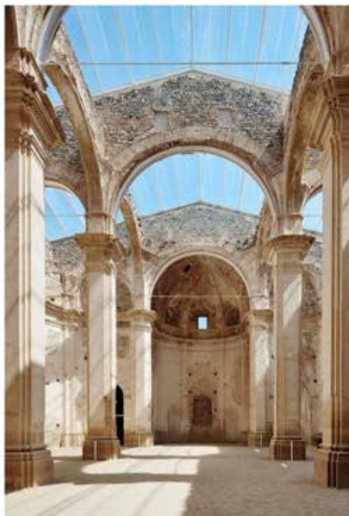
ESGLÈSIA DE CORBERA D'EBRE Ferran Vizoso Architecture
