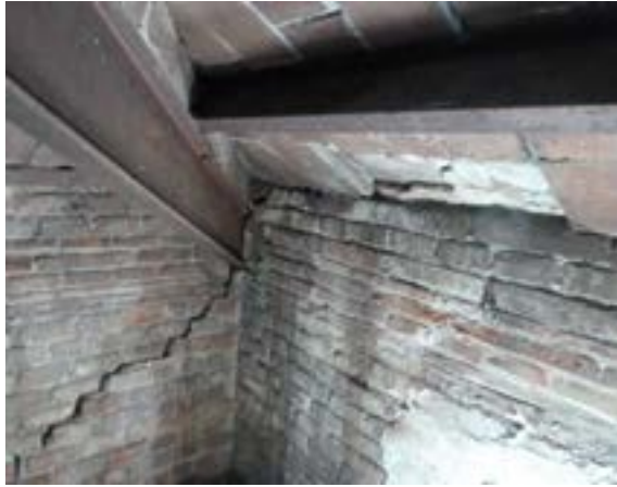
ESQUERDES ALS MURS ON S'ANCOREN PERFILS.
