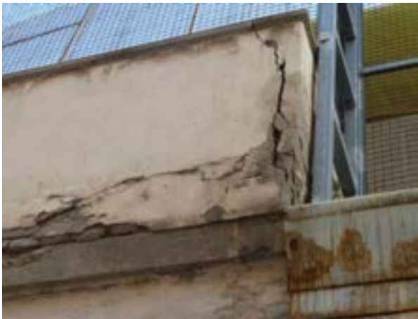
DESPRENIMENTS EN LES ZONES ADJACENTS A LES TORRES DE VIGILÀNCIA
