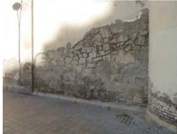
DESPRENIMENTS AL MUR PERIMETRAL.
