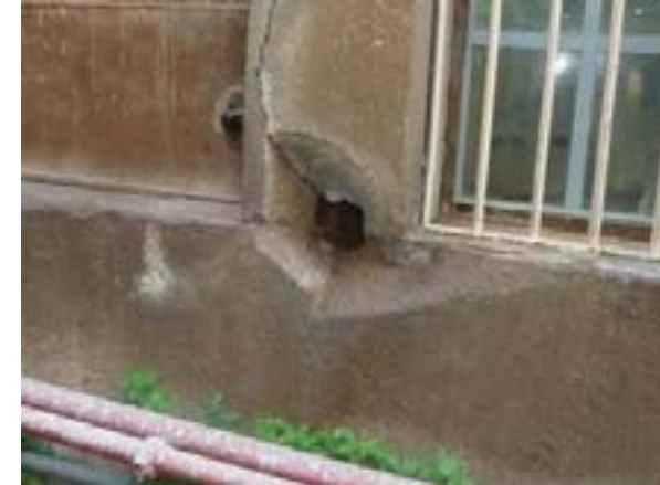
PERFIL EMBEGUT OXIDAT I RECOBRIMENT DESPRÈS.
