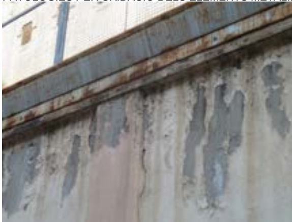
REGALIMS I DESPRENIMENTS A LA CORONACIÓ DEL MUR. ESQUERDES AL VOLTANT D'ELEMENTS OXIDATS.
