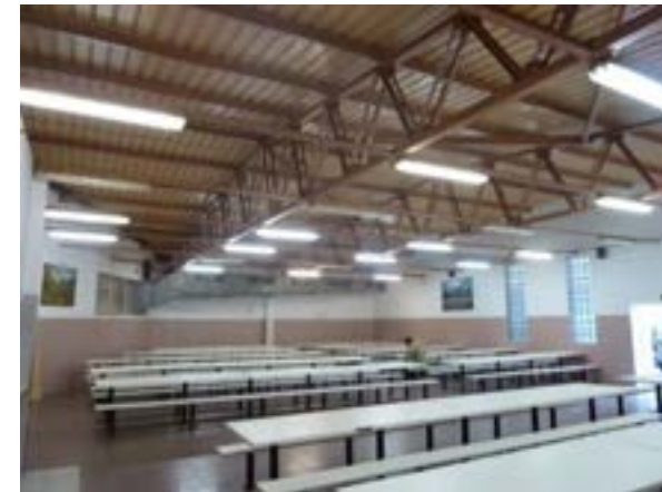
INTERIOR DEL MENJADOR DE LA GALERIA 4 (4).
