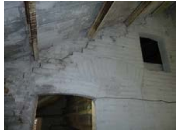
ESQUERDES ALS MURS DE SUPORT DE LA COBERTA.
