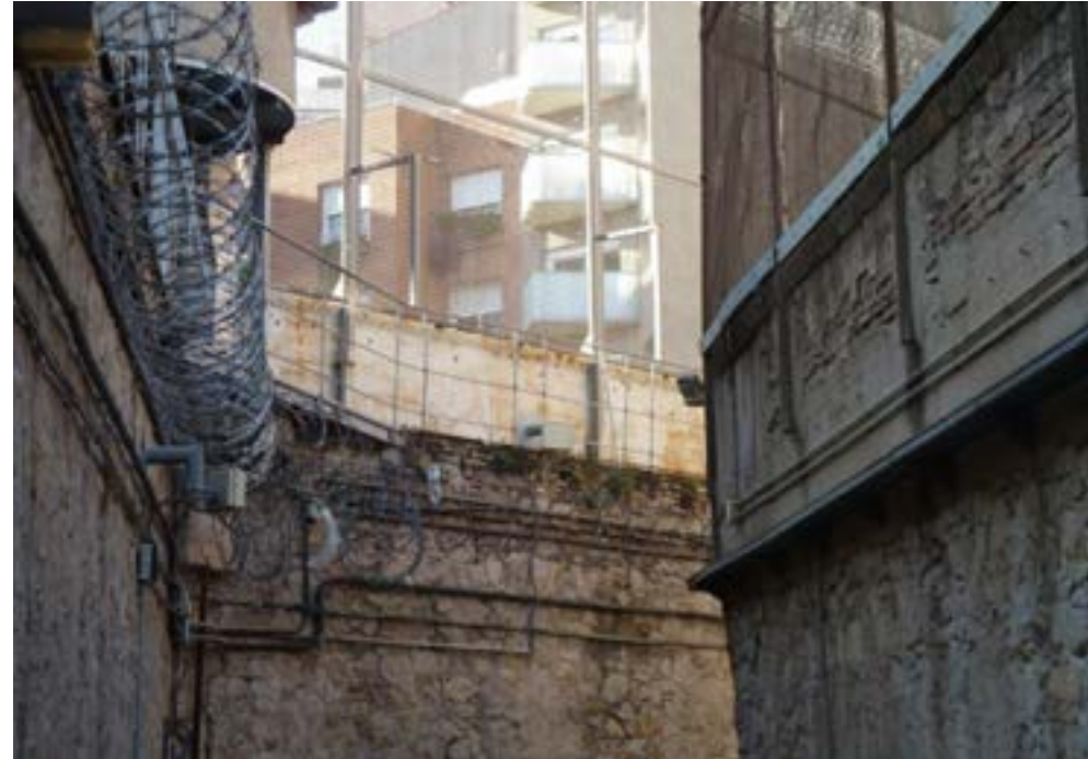
ESTAT GENERAL DELS MURS PERIMETRALS.
