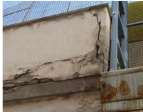
REGALIMS I DESPRENIMENTS A LA CORONACIÓ DEL MUR. ESQUERDES AL VOLTANT D'ELEMENTS OXIDATS.
