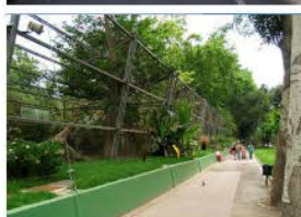
INSTAL·LACIONS OBSOLETES Zones de l'actual zoo amb dèficit de qualitat. Poca traçabilitat de les actuacions que s'hi duen a terme
