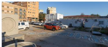
Urbanització del solar del passatge d'Aymà
