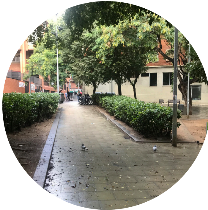
1 MAL ESTAT DE LA VEGETACIÓ ARBUSTIVA PÈRDUA DE VISIBILITAT
