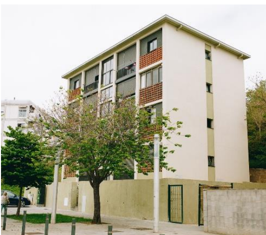
Rehabilitació Fortuna la Marina
