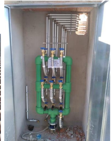
Rehabilitació al Carrer Pons i Gallarça
