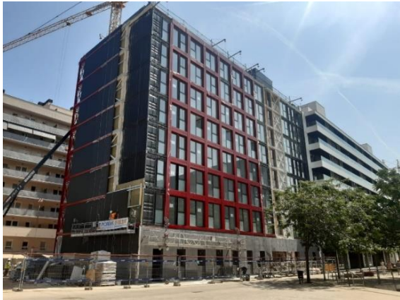
APROP de Glòries, en construcció
