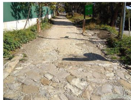
Detalls de l'actuació 1
