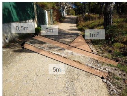
Detalls de l'actuació 3
