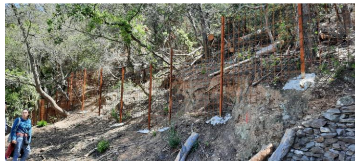
Instal·lació de tanques a les llandes
