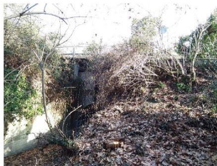
Figura 16 Restes vegetals a retirar en el tram 3.2
