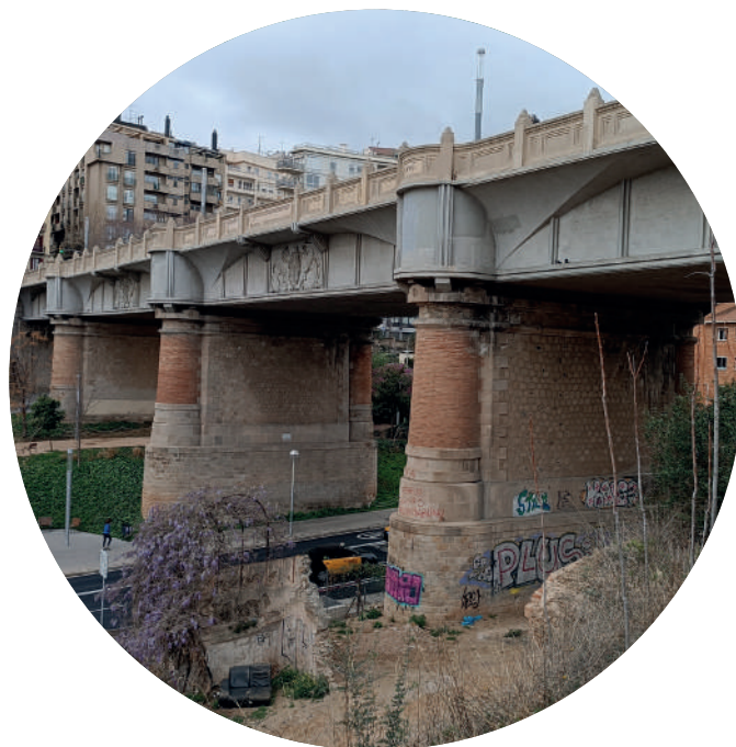
VIADUCTE DE VALLCARCA
