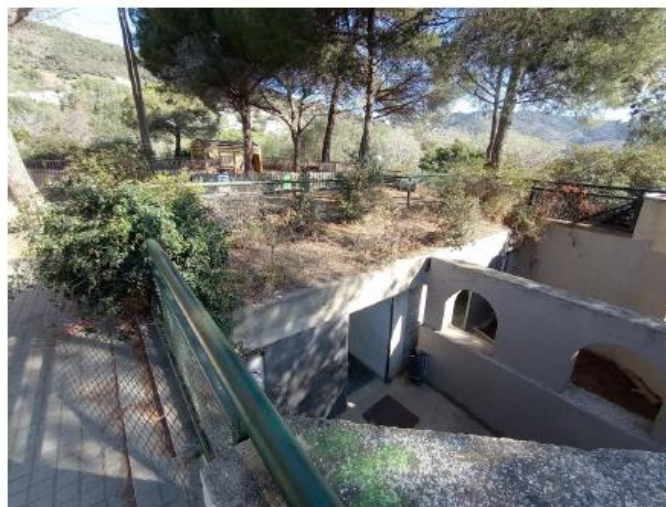
Coberta dels serveis del Parc
