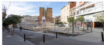
Transformació del solar al carrer Burgos 72
