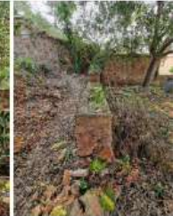
M6 MUR MAMPOSTERIA
