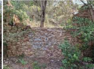
M3 MUR MAMPOSTERIA
