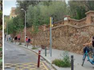
M5 MUR PERIMETRAL
