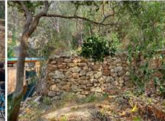
M6 MUR PEDRA SECA
