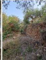
M2 MUR PEDRA SECA
