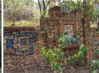
M4 MUR MAMPOSTERIA
