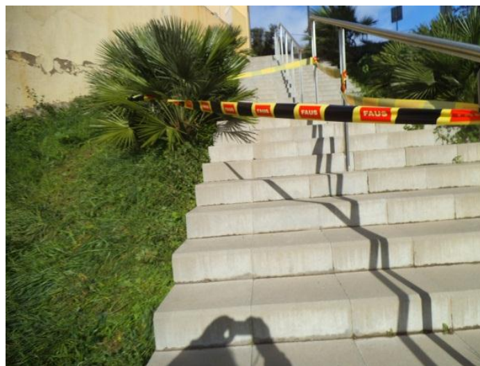
Estat després de l'actuació
