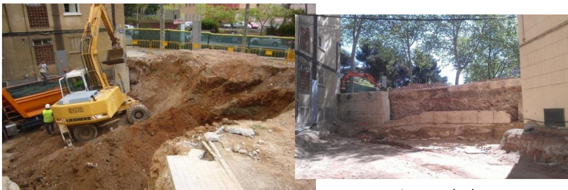
Imatges obres a 20/04/2015
