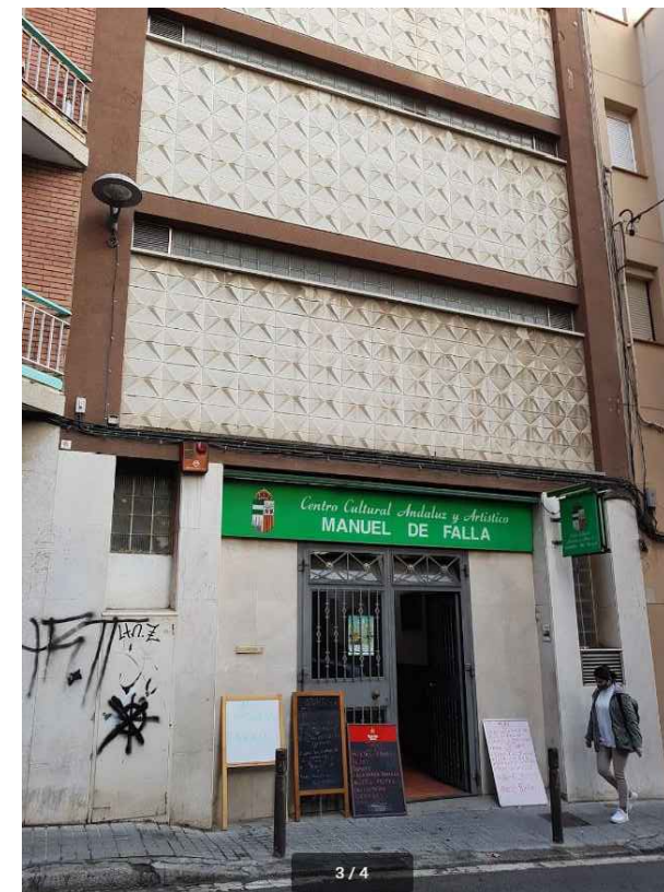
FOTO EDIFICI DES DE CARRER MAS DURAN
