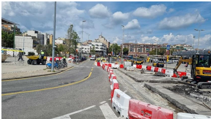
Treballs de segellat de juntes d'ADIF
