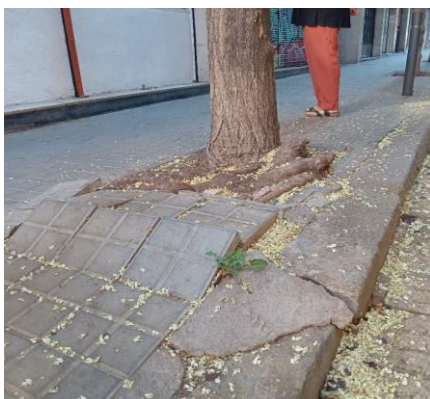
Carrer de Sùria/Riera de Tena (Fotos 21-22)
