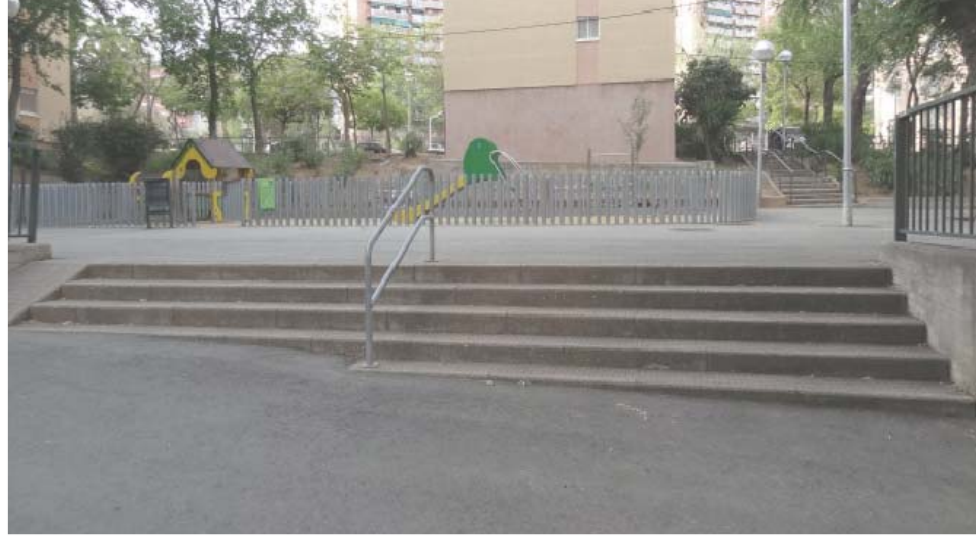
ESTADES A DIFERENT NIVELL. CIRCULACIÓ NO ACCESSIBLE
