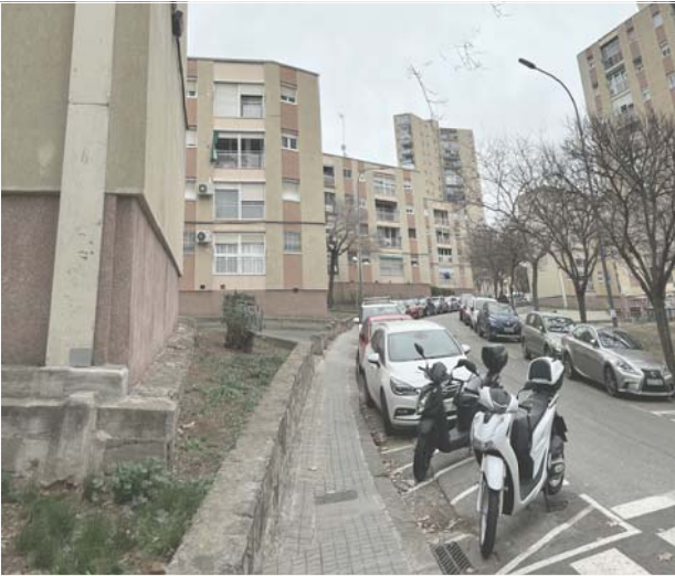
VORERA ESTRETA I AMB FORT PENDENT TRANSVERSAL
