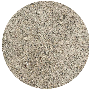
PAVIMENT DE FORMIGÓ DESACTIVAT
