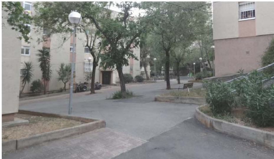
VISIÓ DIAGONAL DE L'ESPAI ENTRE BLOCS
