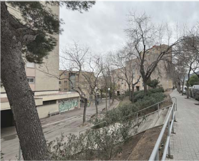
TALUSOS AMB FORT PENDENT
