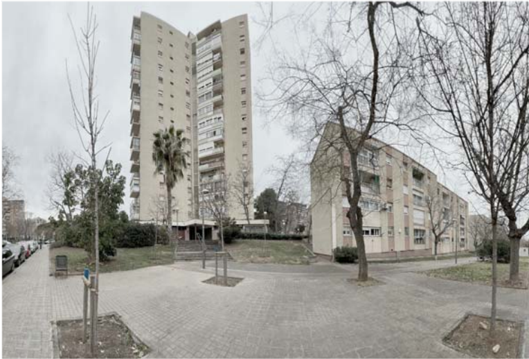
FAÇANA CONTINUA A RAMBLA DEL CAÇADOR
