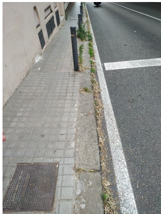
carretera de Sarrià a Vallvidrera, 254 (Foto 13)
