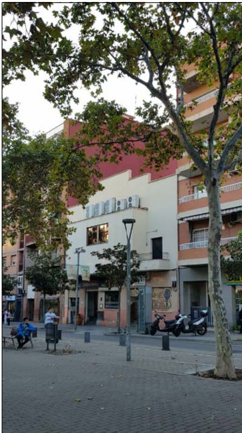
ESTAT ACTUAL - VISTA VIA JULIA
