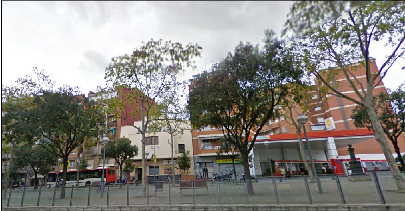
ESTAT ACTUAL - VISTA VIA JULIA
