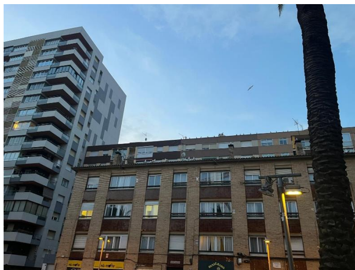
Il·lustració 2. Gavians a les teulades de l'edifici de la Travessera de les Corts, 118
