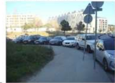
MANCA D'ESPAI PEL PAS DE VIANANTS
