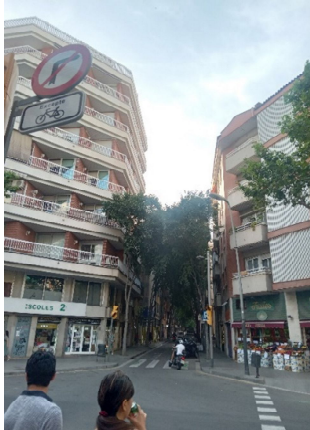
Carrer de la Creu Coberta (Foto 10)
