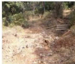
Aterrossament de talussos amb fustes.
