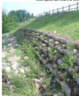
Exemples de murs d'entramat viu executats.
