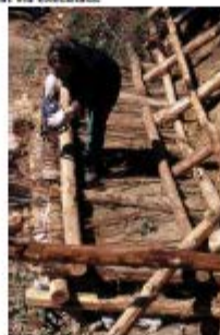
Exemples de murs d'entramat viu executats.
