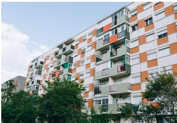
Edifici rehabilitat a c/Vallcivera, Ciutat Meridiana
